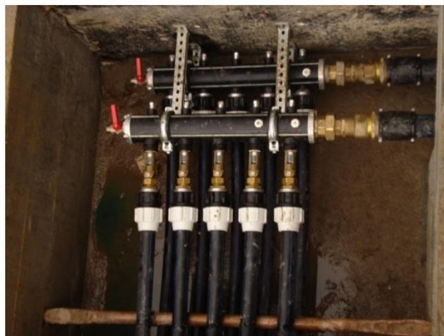
*Figura 6. Colectores de ida y retorno del intercambiador geotérmico*
