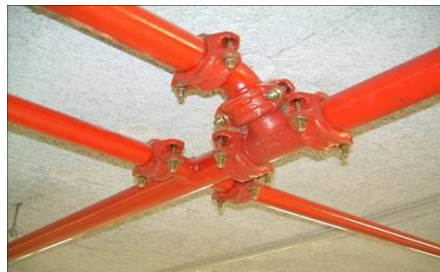
Instalación en Acero
