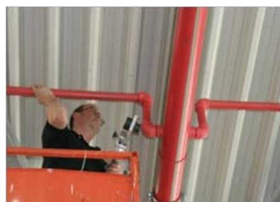
Instalación tuberías PP-R faser
