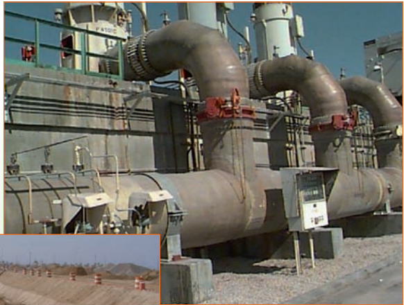
Instalación enterrada de una conducción DN2800 PN6
