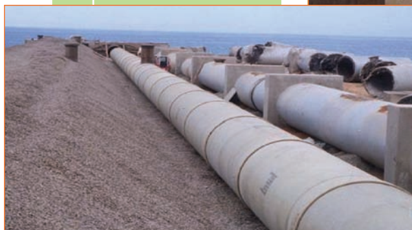
Instalación aérea de tuberías de PRFV
