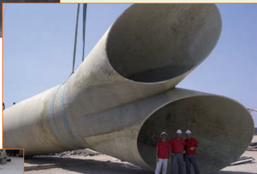
Pantalón de descarga. DN2300 PN3
