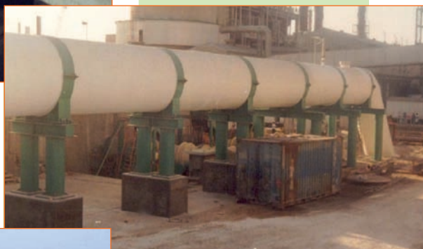
Instalación aérea de tuberías de PRFV
