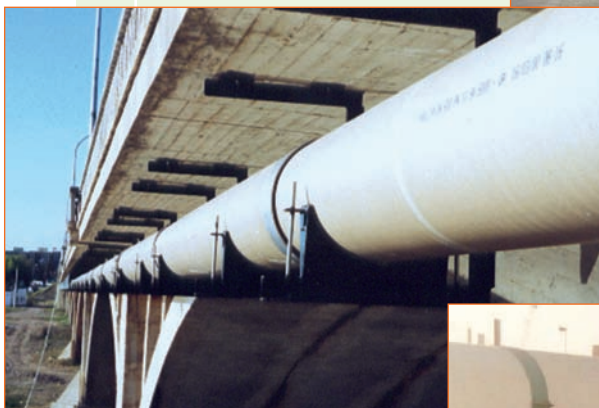
Instalación aérea de tuberías de PRFV
