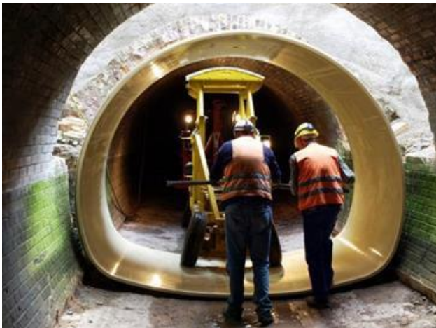
Ilustración 9. Sistema de empujes y desplazamiento de tubos PRFV NC
