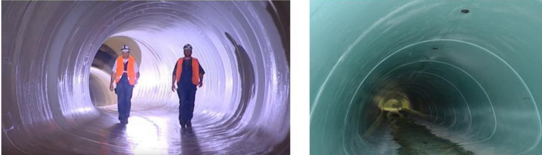
Ilustración 10. Resultado de la rehabilitación
