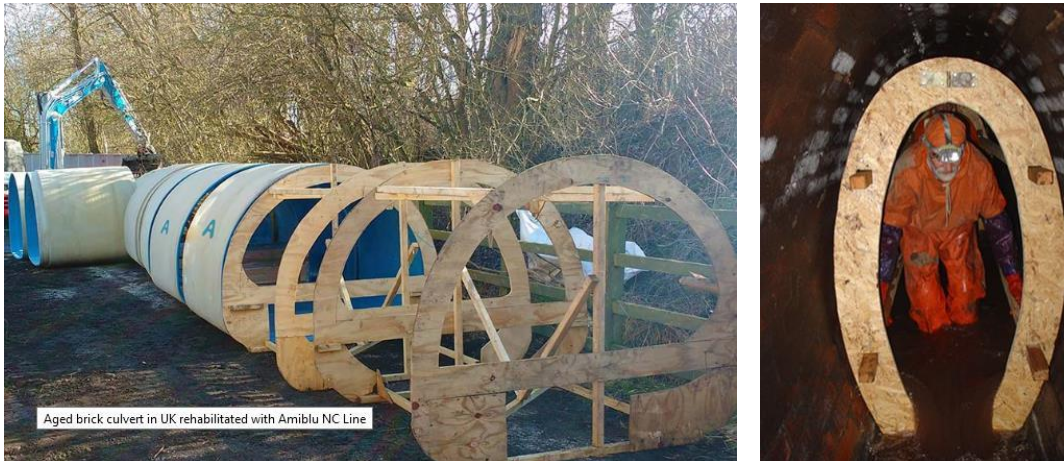
Ilustración 7. Plantillas de inspección
