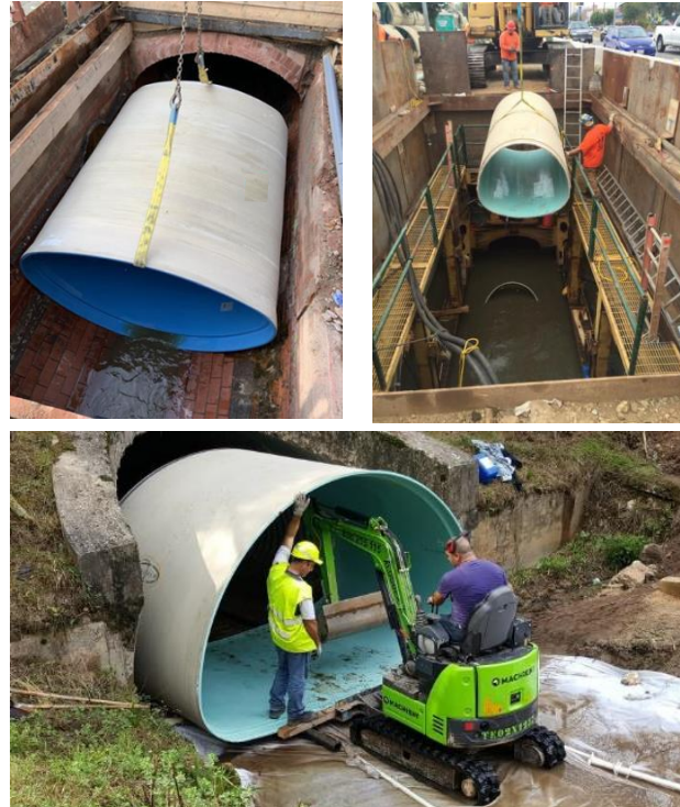
Ilustración 8. Ejemplos de montajes de tuberías de PRFV NC
