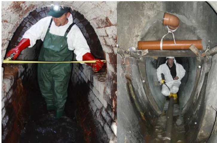
Ilustración 6. Inspección de la conducción a rehabilitar
