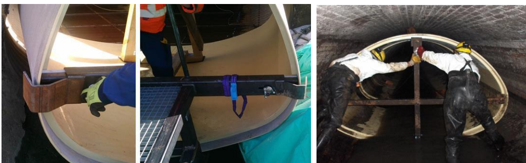
Ilustración 11. Ejemplos de cruz de empujes
