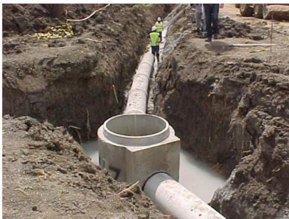
Figura 1. A la izquierda, red de saneamiento en hormigón. A la derecha, red de saneamiento en material plástico
