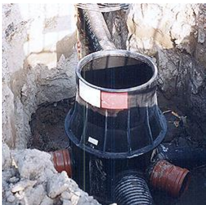
Figura 2. A la izquierda, pozo instalado en confluencia de colectores. A la derecha, pozo instalado en cambio de dirección
