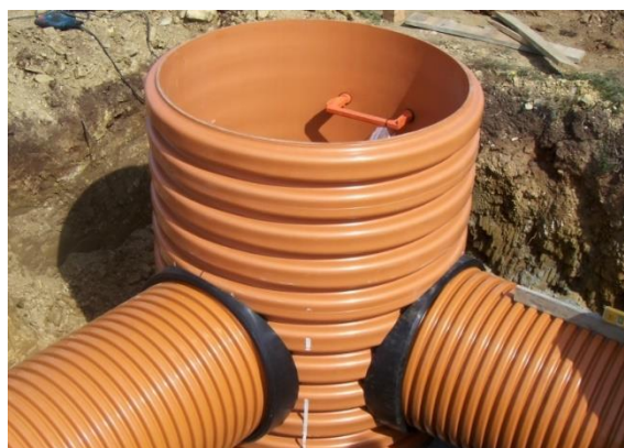
Figura 2. A la izquierda, pozo instalado en confluencia de colectores. A la derecha, pozo instalado en cambio de dirección
