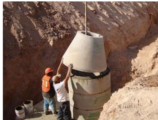
Figura 6. Diferencias entre la instalación de un pozo plástico y un pozo de hormigón
