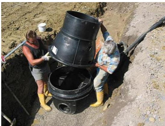
Figura 6. Diferencias entre la instalación de un pozo plástico y un pozo de hormigón
