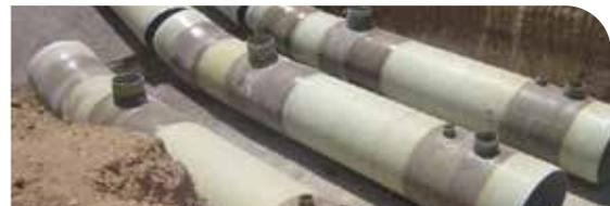
las **bridas**, fabricadas también en PRFV, que permiten la conexión a cualquier equipo mecánico (válvulas, ventosas, etc)
