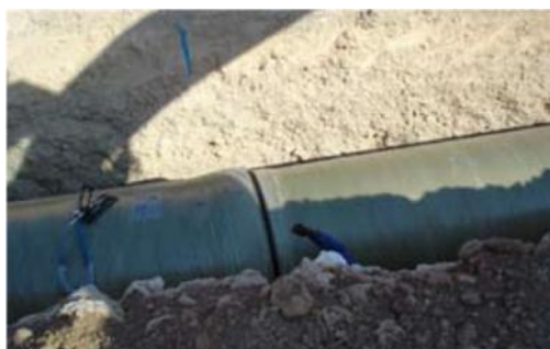
Introducción de la primera junta tórica dentro de la Campana
