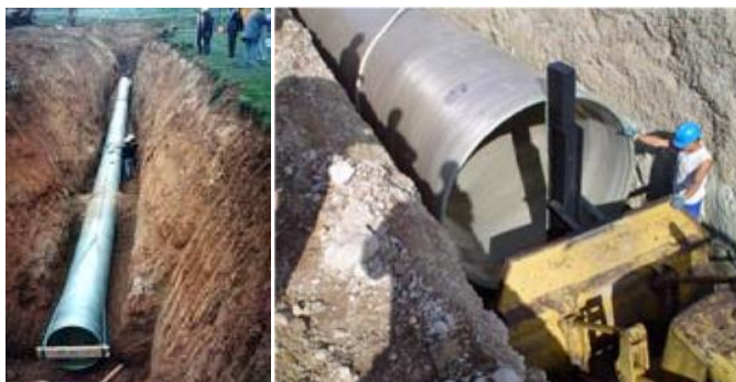
Los extremos de las tuberías de PRFV se deben proteger de cualquier golpe
