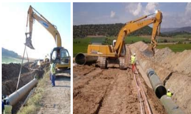
Instalación de tubería mediante el movimiento de la máquina giratoria
