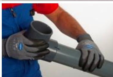
7. Limpiar el interior de la instalación con el líquido limpiador específico de PVC y un paño limpiador (sin pelusa). La limpieza garantiza una superficie sin grasa ni suciedad y también proporciona un pretratamiento químico para preparar las superficies para la unión. Deje que las partes se sequen correctamente para reducir las posibilidades de condensación.
