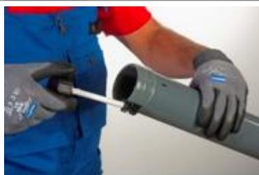
10. Insertar los elementos de inmediato con un movimiento fluido y uniforme. En una buena unión se forma, en la transición de la tubería y el accesorio, un anillo cerrado y uniforme de adhesivo visible.
