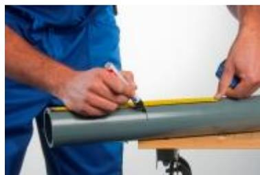
2. Cortar la tubería en ángulo recto a la longitud correcta con una sierra específica para tuberías de PVC o utilice la sierra de cable para los lugares de acceso difícil.
