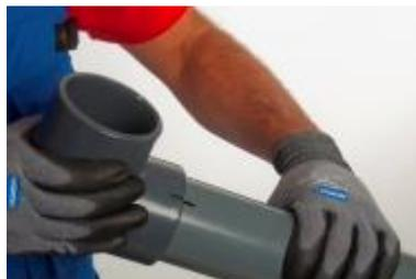
11. Retirar el exceso de adhesivo inmediatamente con un paño limpiador. El exceso de adhesivo puede dañar la tubería y, por tanto podría debilitarla.
