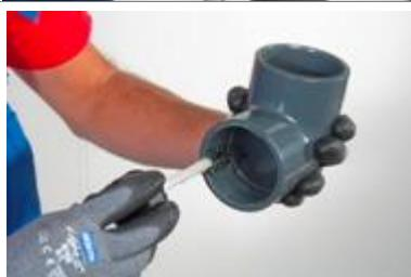
9. Aplicar una capa un poco más gruesa en el extremo de la tubería. No utilice demasiada cantidad de adhesivo.
