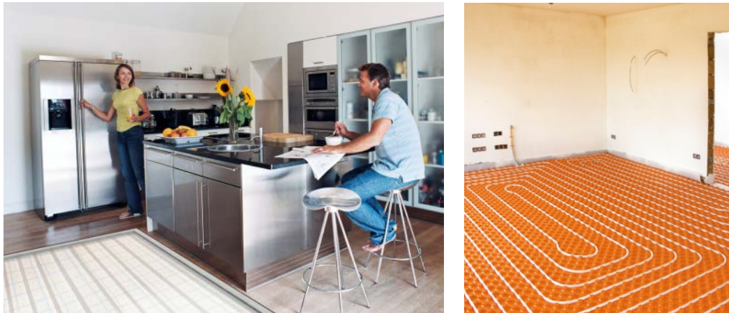
Figura 4. Suelo radiante
