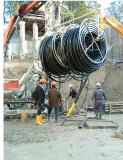
Al mismo tiempo que la sonda se introduce el tubo de inyección para poder realizar el relleno del pozo con un mortero especial de alta conductividad desde el fondo hasta la superficie del pozo. Después del relleno se realizarán de nuevo las pruebas correspondientes.
