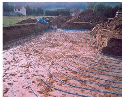
Las **cimentaciones termoactivas** son elementos estructurales de hormigón en las que se utilizan como intercambiadores para captar el calor del subsuelo tubos de polietileno alojados en el interior de la cimentación del edificio, en pilotes, pantallas subterráneas, muros de contención, losas... sujetos a las armaduras del hormigón. Son instalaciones económicas, al aprovecharse de instalaciones necesarias en la construcción de las edificaciones.
