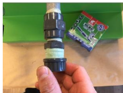
Fig. 2: Aplicación cinta de sellado impregnada y reforzada con fibra.
