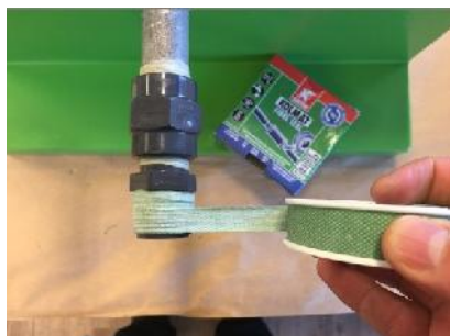
Fig. 2: Aplicación cinta de sellado impregnada y reforzada con fibra.
