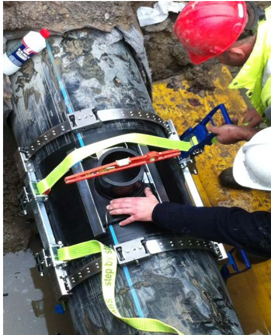
Figura 8. Fijación y preparación de toma para su soldadura al tubo de PE
