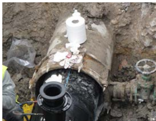
Figura 9. Inserción de elementos laterales
